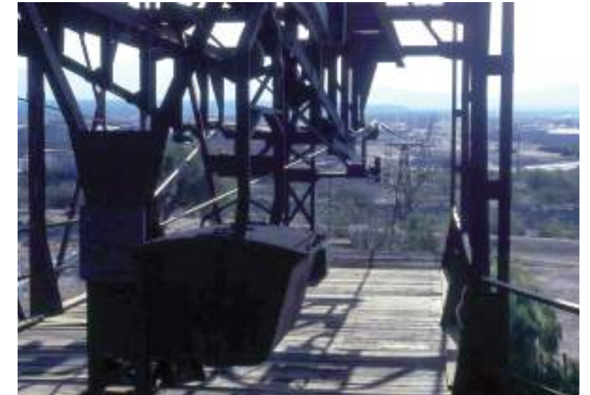
Figura 4. Vista desde la estación N° 1 hacia los Nevados del Famatina (al fondo) y detalle de las vagonetas de carga. Mientras que desde la mina éstas transportaban el mineral pendiente abajo, desde la estación N° 1 se enviaban hacia la mina alimentos, herramientas y correspondencia, entre otros. Fotografía: Enrique Miranda.
