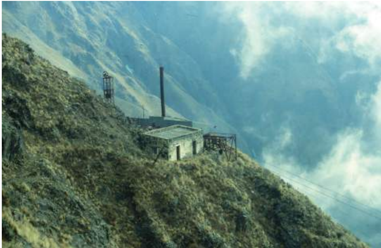
Figura 6. Vista panorámica de la estación N° 6. Fotografía: Enrique Miranda.
