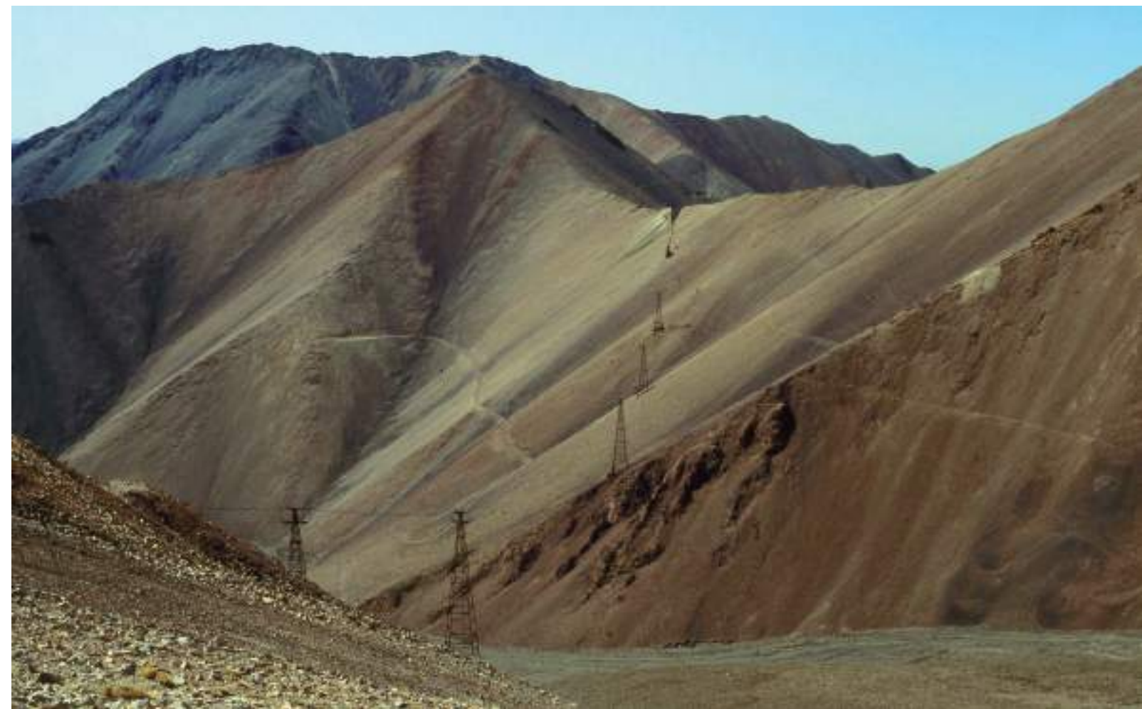
Figura 5. Tendido del cablecarril desde la boca de mina hacia la estación N° 8. Vista hacia el sudoeste. Fotografía: Enrique Miranda.
