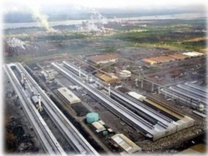
Figura 8. Vista aérea de la reductora CVG Alcasa, pionera del sector aluminio, ubicada en la zona industrial de Matanzas en Ciudad Guayana. Cuenta actualmente con dos (02) líneas de producción, las llamadas Línea III y Línea IV. La primera cuenta con 180 celdas de reducción de aluminio y la segunda con 216, para un total de 396 celdas de producción (Tineo, 2016). Imagen institucional de CVG Alcasa tomada de internet.
