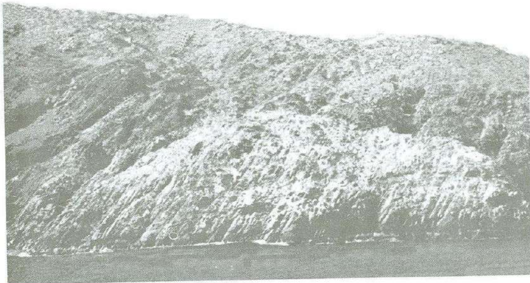
Fig. 7. Foto del sistema principal de diaclasa de rumbo general Norte – Sur, mostrando su estrecho espaciamiento y el fuerte buzamiento al NE.
