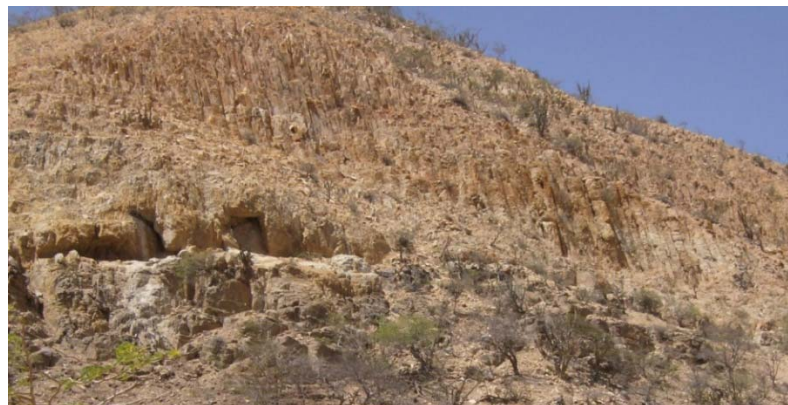
Fig. 32. Diaclasamiento que afecta a las Volcánicas de Ipapure en el cerro Guasosopo, sobre el contacto con la Formación Rancho Grande.
