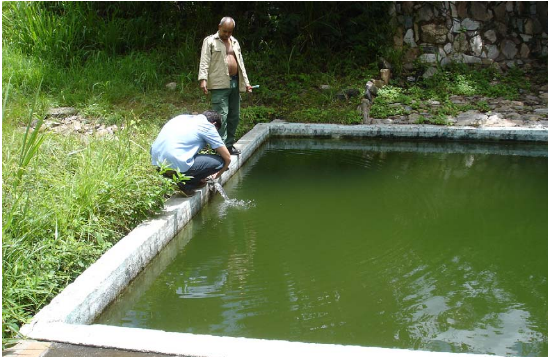
Tubo que conduce todo el caudal de la fuente termal natural a la primera piscina.
