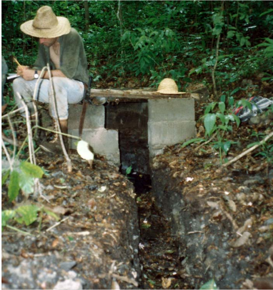
Fig. 7. Manantial Agua Negra. Tanquilla donde se almacena el agua.
