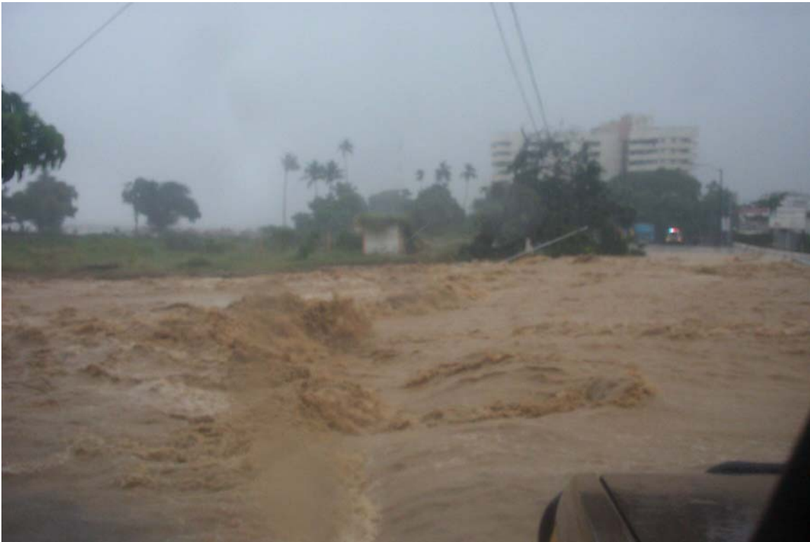
Figura 10: Otra imagen del desbordamiento por un lado del puente. Nótese la poca densidad del agua. Fotografía: Rogelio Altez.
