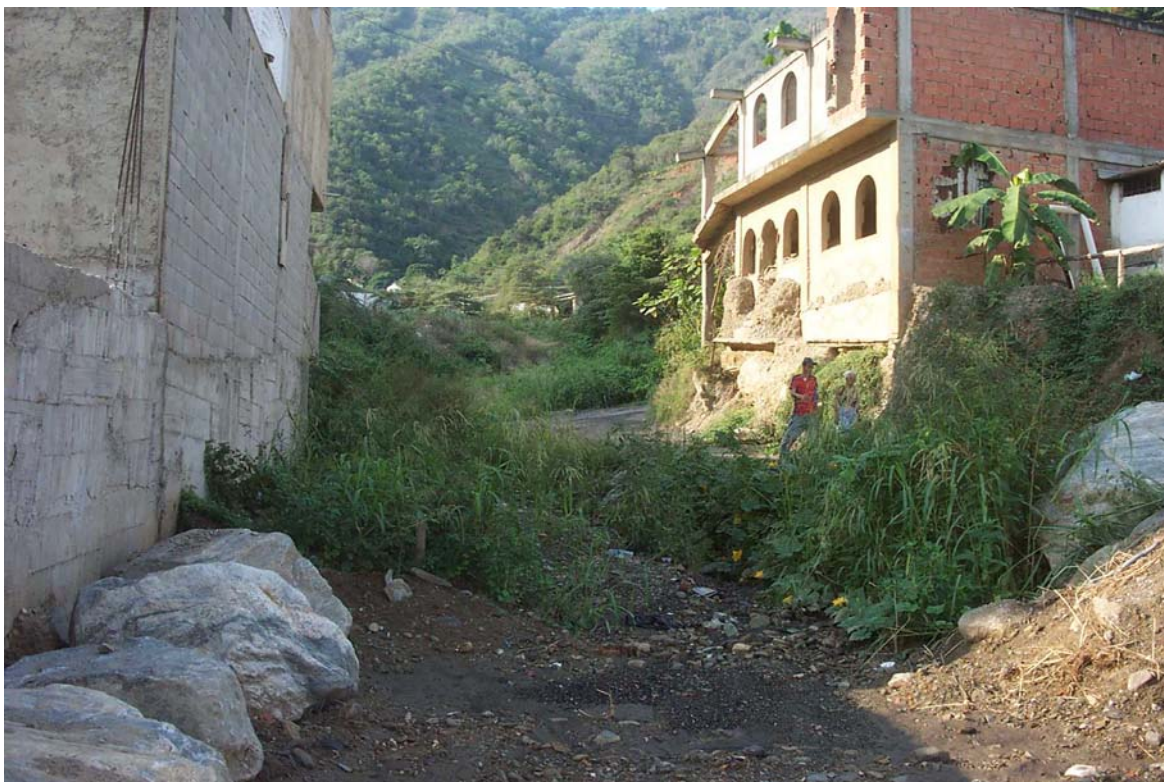
Figura 28: Imagen del barrio Quebrada Seca, conviviendo con el cauce, tomada en octubre de 2004. Fotografía: Rogelio Altez.
