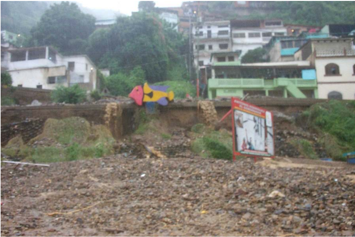
Figura 56: El mismo deslizamiento de cerca. Fotografía: Rogelio Altez.
