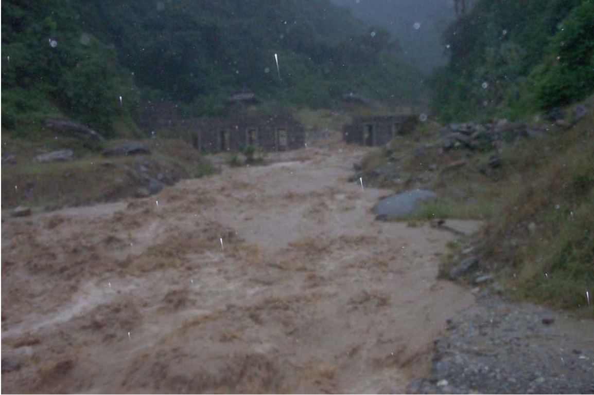
Figura 17: Más arriba en el cauce de Camurí Chico, se observan las aguas pasar por el dique recientemente construido para detener flujos de sólidos. 8 de febrero, 1 p.m. Fotografía: Rogelio Altez.
