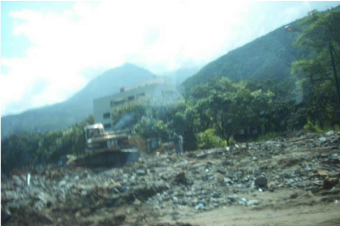
Figura 36: Altura de los sedimentos y basura arrastrados por las aguas en Tanaguarena. 11 de febrero. Fotografía: Rogelio Altez.
