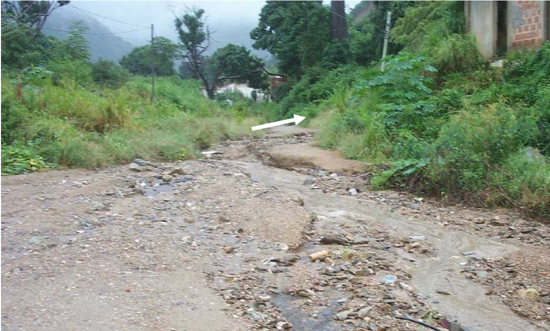
Figura 41: Inicio de la caída de aguas a pocos metros de la fuente antes señalada, identificada en esta imagen con la flecha. Fotografía: Rogelio Altez, tomada el 8 de febrero.
