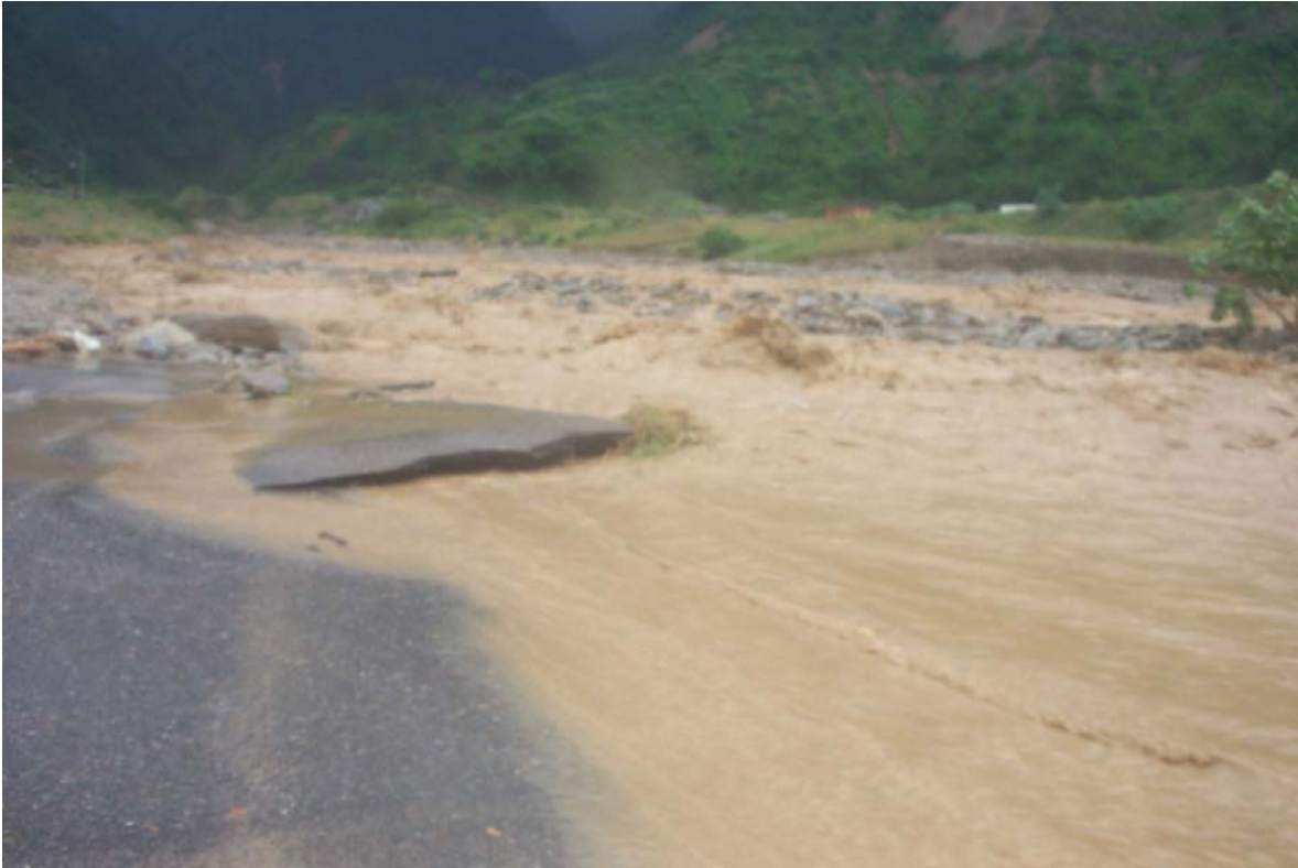
Figura 25: 9 de febrero, imagen tomada sobre el paso del río en la vía. Asfalto cediendo. Fotografía: Rogelio Altez.
