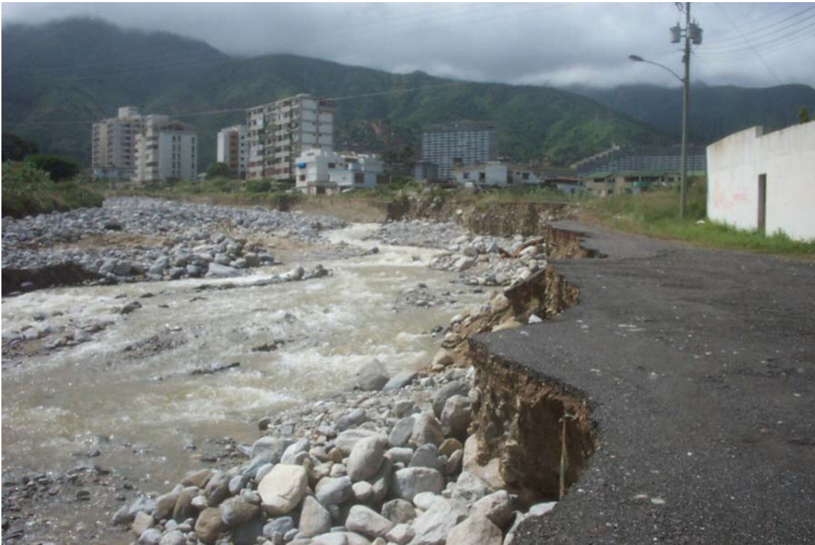
Figura 12: Consecuencias del avance sobre las márgenes del cauce. Imagen tomada desde el mismo lugar el 11 de febrero. Obsérvese la gran cantidad de rocas pequeñas en medio del cauce. Fotografía: Rogelio Altez.
