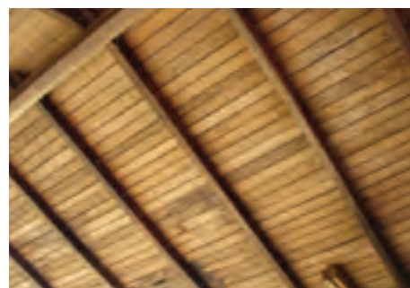
Foto 8. Construcción (techo) con mapora ( Roystonea oleracea ), Yaracal, cuenca del río Tocuyo, estado Falcón. Giuseppe Colonnello
