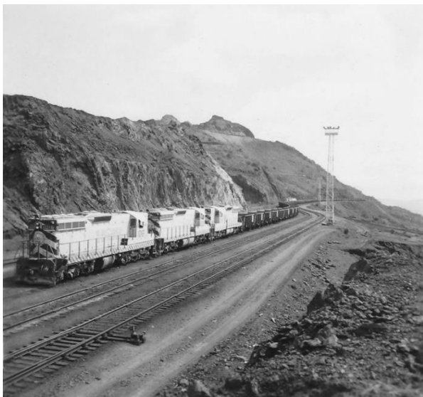
Figura 42. Ferrocarril transportando en vagones la mena de hierro extraída del Cerro Bolívar. Fotografía tomada por Alex Lorenz (1960-61).
