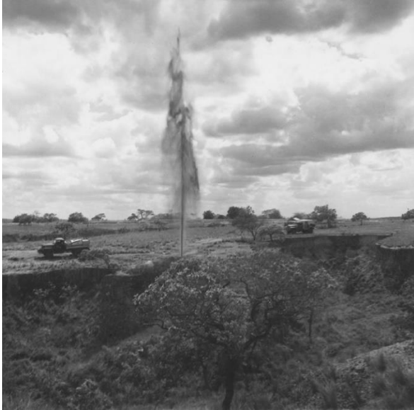
Figura 31. Detonación de carga explosiva con “soplo” para generar y adquirir datos sísmicos (1950-52). A la izquierda el camión de explosivos y a la derecha el camión con el sistema para grabación. Fotografía tomada por Alex Lorenz.
