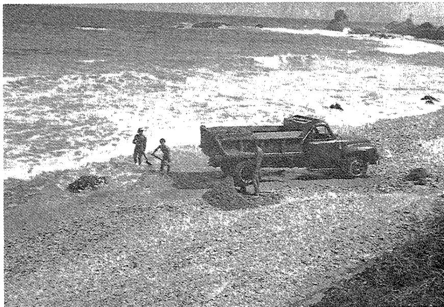
Figura 45. Extracción de grava en playas del Tramo de Los Caracas, al pie del talud de relleno de la Carretera de La Costa.
