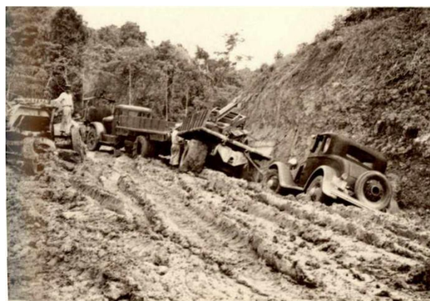
Figura 10. Carretera Cachipo - Quiriquire en la década de los años '30. El vehículo Ford 1932 del fotógrafo aéreo George De Witt siendo remolcado por un tractor oruga de la Standard Oil of Venezuela, junto con otros dos camiones atascados en el fango, lo que ilustra perfectamente las condiciones de las carreteras en los campos petroleros de la región oriental durante aquella época. Tomado de Lagoven (1985).
