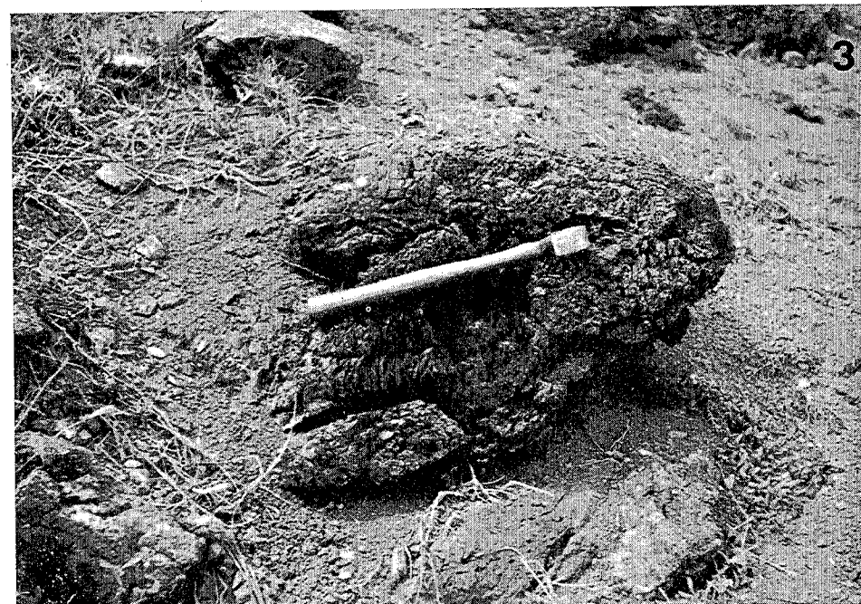
Foto 3. Pliegue intraformacional en el "chert" estratificado de la Formación Pampatar, al sur de la Laguna de Agua de Vaca
