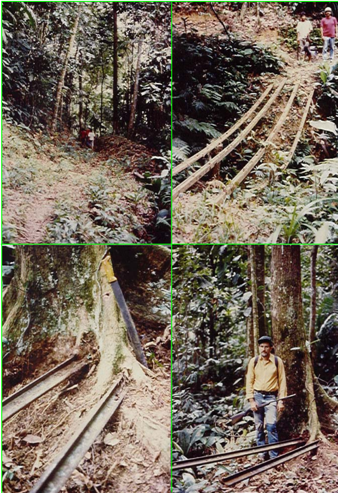
Camino hacia Buena Esperanza (hoy Fundo Sapo Escondido), el cual sigue el trazado del viejo ferrocarril. Nótense el árbol que en su crecimiento ha rodeado a los rieles.
