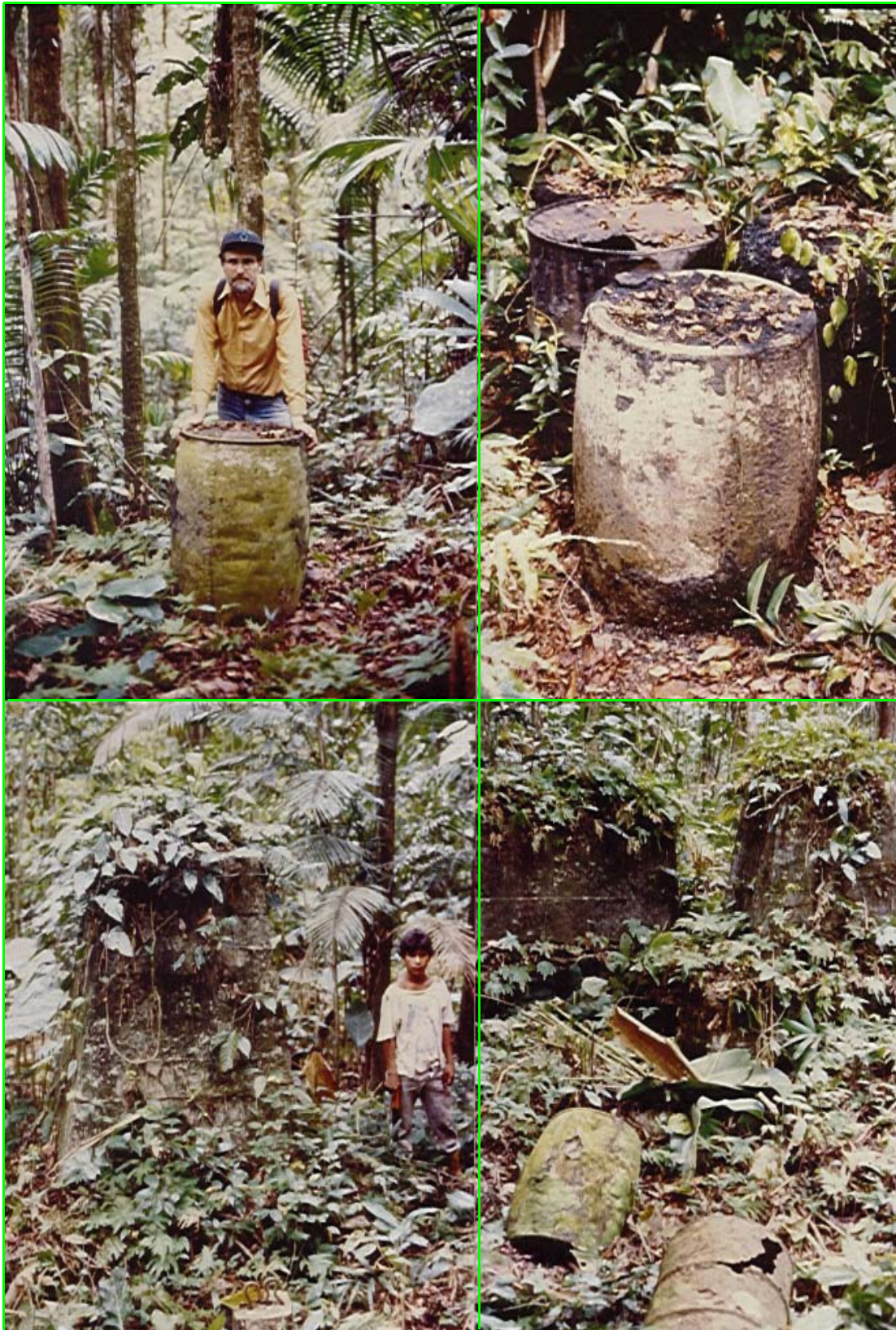
Arriba aparecen varios bidones, algunos todavía llenos de petróleo. Abajo entre la maleza aparecen tres de los cuatro pilares de concreto donde se encontraba montada la cabria de perforación del pozo PEBIY-1
