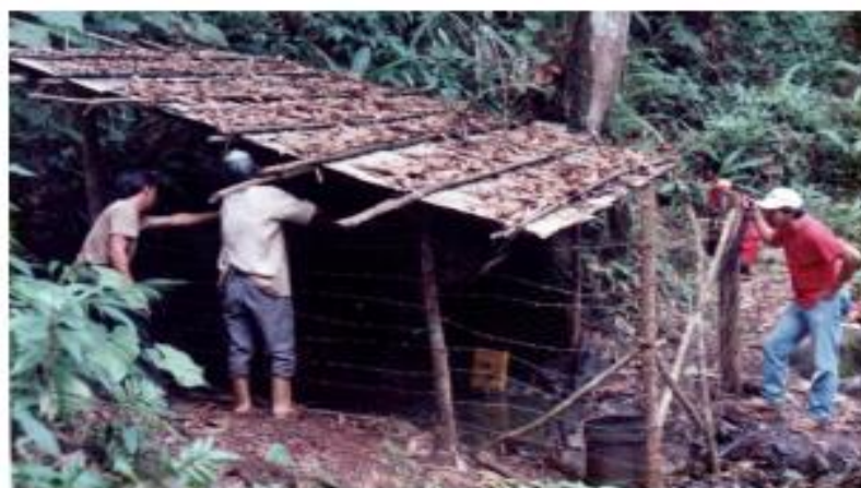
Figura 15. Mene Tr.7 techado y cercado para que no se ensucie con hojas. Tomado de URBANI & GALARRAGA (2016).
