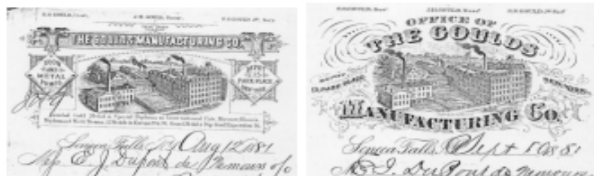
Ilustraciones de las instalaciones de la empresa The Goulds Manufacturing Company. Fuente: DuPont Co. Records, acc. 500, series I, box 114. Copias autorizadas por Hagley Museum & Library, Wilmington, Delaware.
