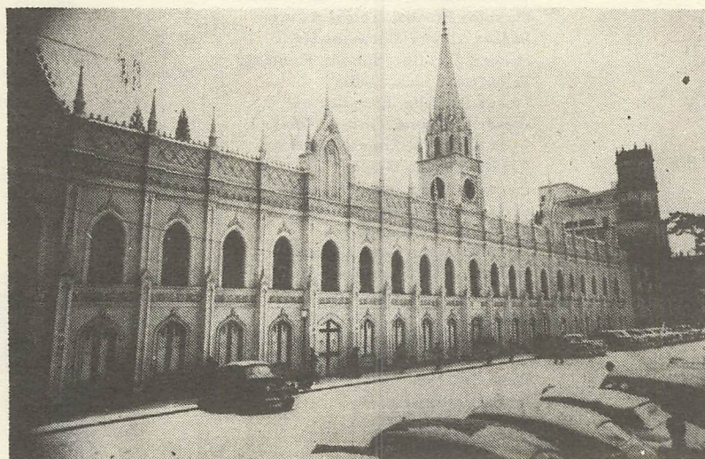
Fachada norte de la Universidad Central cuando funcionaba en el antiguo Convento de San Francisco, hoy Palacio de las Academias. (Fotografía de los años treinta). Frente a la Universidad estuvo una estatua del Gral. A. Guzmán Blanco derribada en 1889. Para el bicentenario de la Universidad, había un jardín donde está la calle
