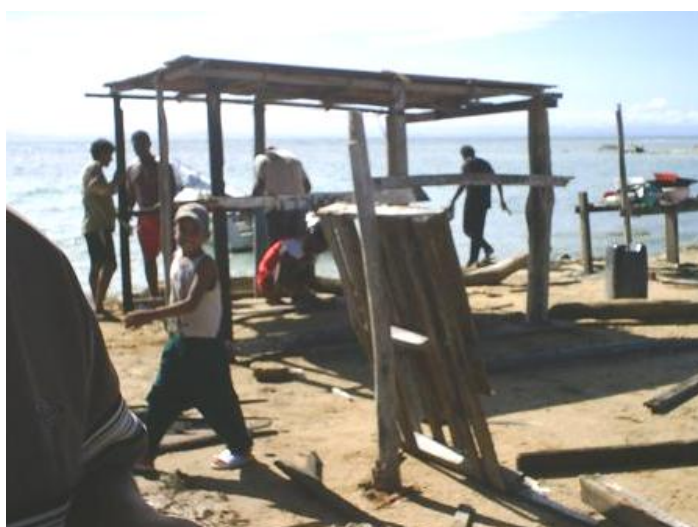
Foto 19. Vivienda en construcción en las inmediaciones de las ruinas de Nueva Cádiz.
