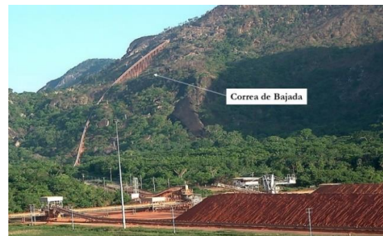
Figura 3 – Visión general de los patios de homogeneización y apilamiento de Pie de Cerro, a 80 msnm, con la "correa de bajada", a la izquierda de la imagen, equipo estratégico compuesto de una cinta y cables de acero en vez de rodillos, que alcanza pendientes hasta de 18°, a una tasa operativa de 1.600 t/h, equivalente a 4 m/s y permite transportar la bauxita triturada desde la mina, a 650 m s.n.m., a través de un trayecto de 4,2 km. Imagen: Oscar Portes (2003).
