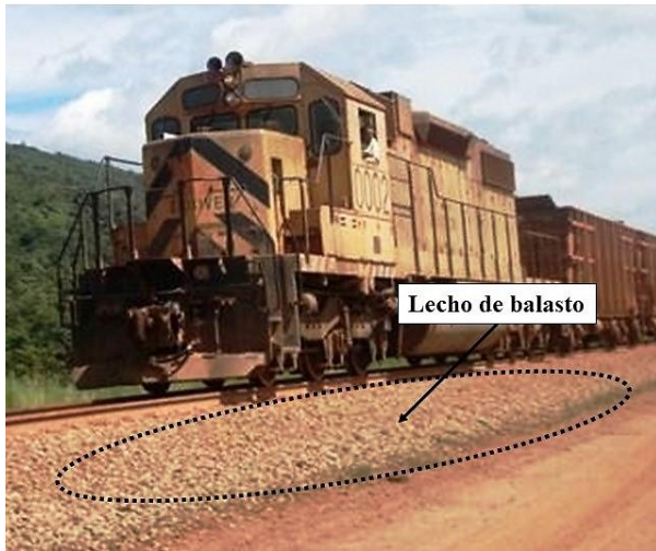
Figura 10. Detalle de un lecho de balasto que soporta la estructura de la vía férrea de un ferrocarril de carga, en este caso, el tren de transporte con bauxita entre los patios de homogeneización y el muelle, en Los Pijiguaos. Para esta operación, el balasto como árido, tiene 4'' de diámetro promedio (10 cm) y la capa, una altura por norma de 12'' (30 cm).
