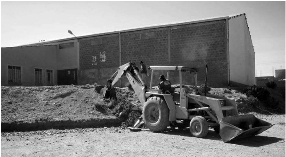
FIG. 5.2.2.7. Escarpe de la falla Huancarani en la zona de Ludoteca (Foto: Terán, 2006).
