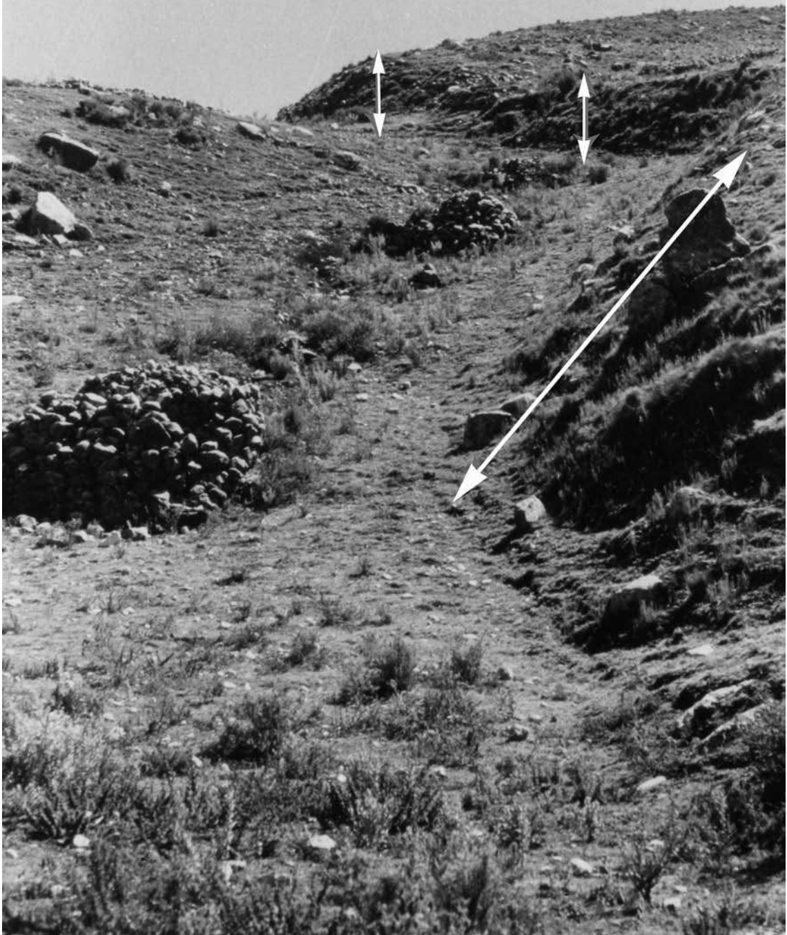
FIG. 5.2.5.4. Fotografía de campo del escarpe de la falla de Chaquibamba, de 80 cm de altura.
