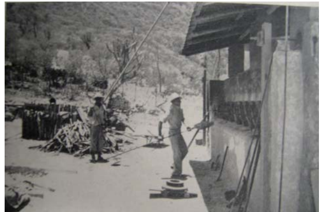
Figura 9. Horno de retortas tipo "Gould" para la extracción de mercurio. Tomado de LÓPEZ & BRINEMAN (1943: 52).
