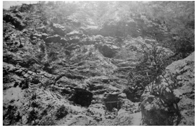
Figura 8. Trabajos mineros de San Jacinto en 1942. En la parte centro-inferior aparece la bocamina del túnel "Traviesa", con un soporte de madera y un hombre al frente. Nótese una serie de escalones excavados en la ladera para acceder a las bocaninas superiores. Tomado de LÓPEZ & BRINEMAN (1943).
