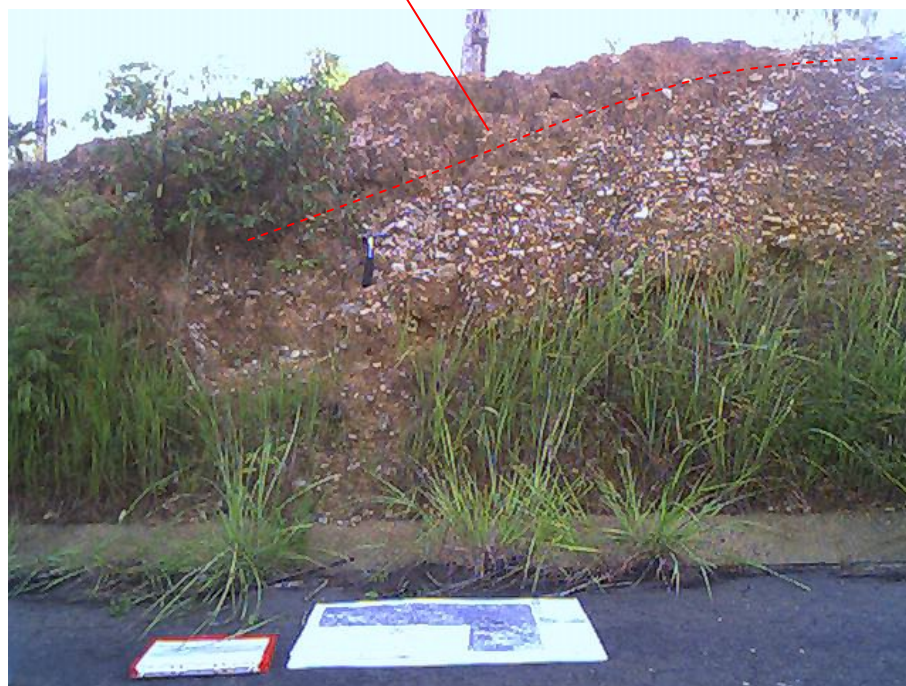
Figura 6.33. Basculamiento hacia el norte y flexura en el sector de Caituco. Rumbo de la foto O-E.
