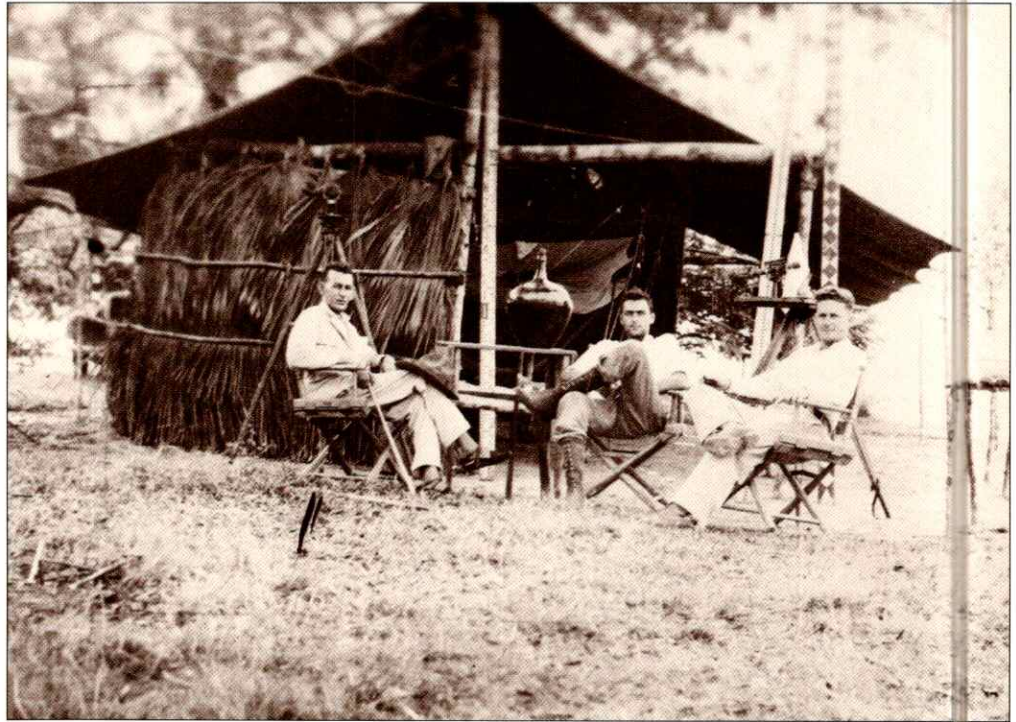
Trabajos de Campo, Monagas, 1933.
