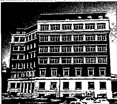
Edificio Sede Altos Hornos
