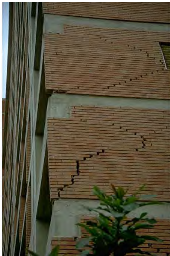
Edificio Petunia I. Izquierda: representación de daños en paredes transversales (adaptado de Arcia & Malaver, 1974); derecha: daños en paredes de fachada (Steinbrugge, 1967)
