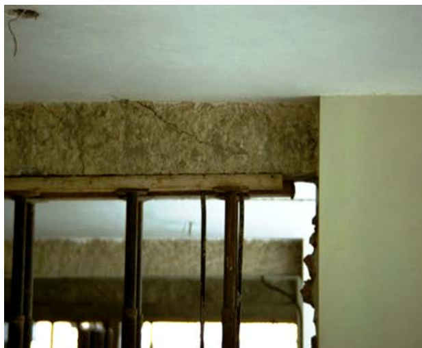
Daños en vigas y losas (Steinbrugge, 1967)
