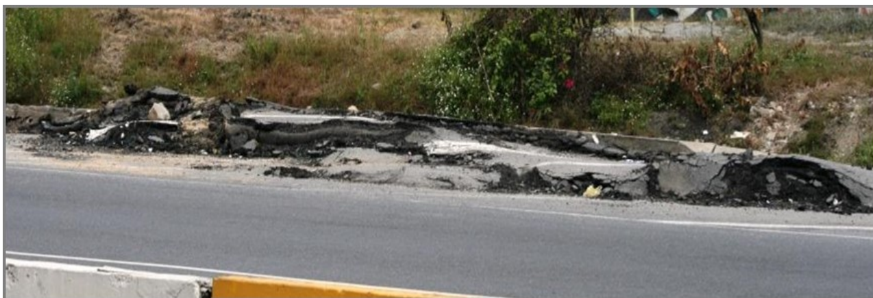
Figura 7-5: Pliegues del pavimento de más de 40 cm afectaron el sobre ancho. (Autor: Páez-Pumar, 2011).
