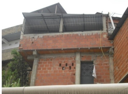
Figura 9-6: Tipologías estructurales típicas de las viviendas populares.
