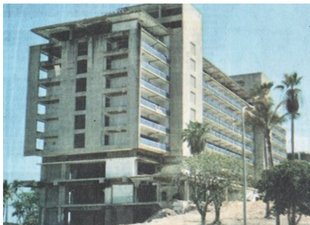
Figura 2-17: Solución al problema de la discontinuidad de rigideces a nivel de Mezzanina. (Fuente: Mazzeo, 2004).
