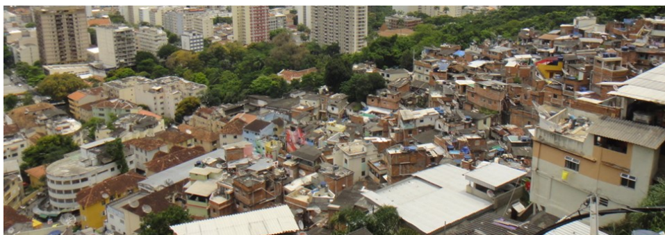
Figura 4-19: Hábitat autoconstruido y vulnerable. (Autor: Hmaglione10, 2012). 25
