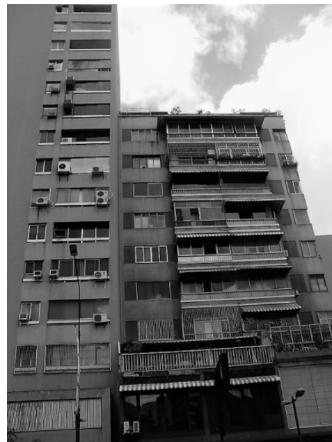
Figura 5-4: Estructuras adosadas en Caracas
