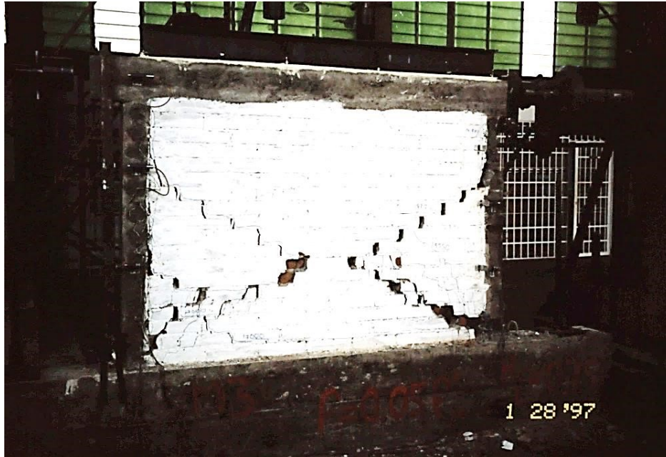
Figura 4-12: Ensayo de muro de mampostería bajo cargas alternantes. (Autor: Lafuente, 1997).
