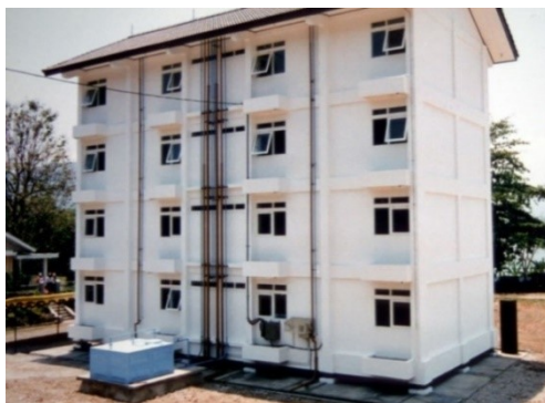
Figura 6-11: Edificación en Java, Indonesia, construida con el plano de aislamiento sobre el terreno. (Fuente: Kelly, 2013)
