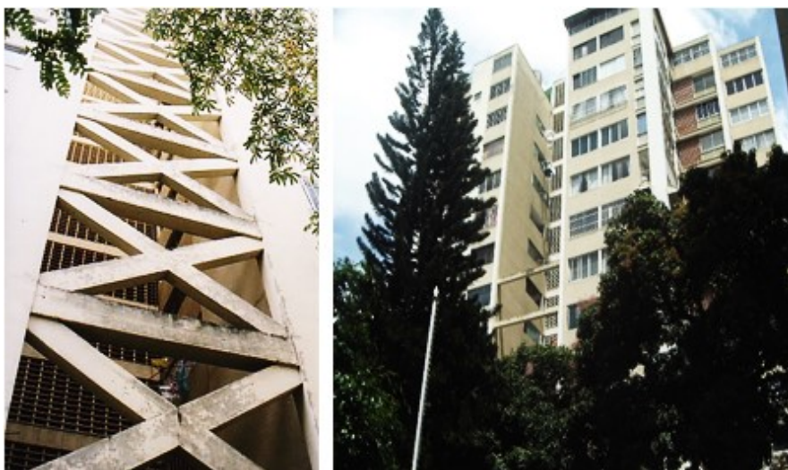
Figura 2-27: Adecuación en edificaciones nominalmente iguales.
