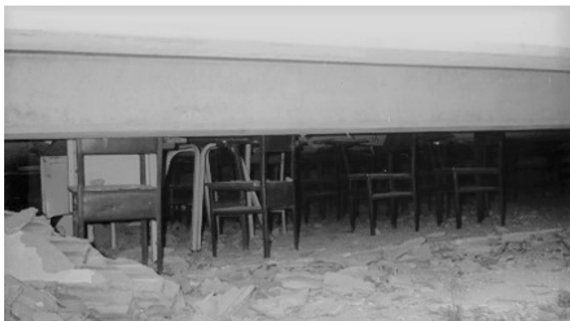
Figura 5-6: Espacio dejado por los pupitres al sostener la losa de techo y las vigas de la estructura. Terremoto del Pilar, Cumaná 1997. (Autor: Centeno Werner, 1997).
