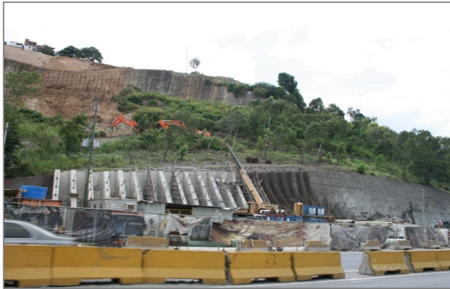
Figura 7-6: Refuerzo de pantalla atirantada. (Autor: Páez-Pumar, 2011).
