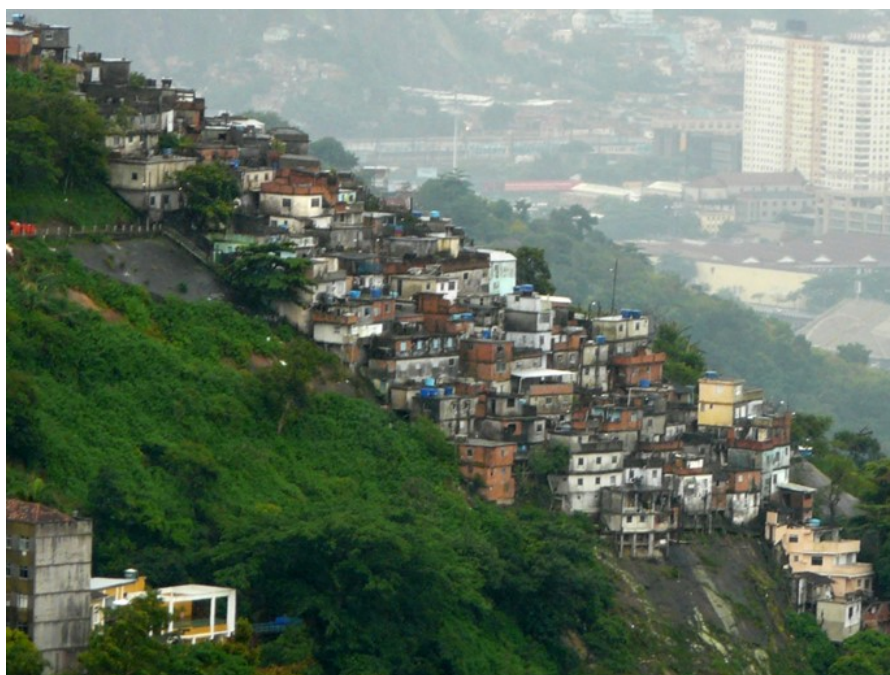
Figura 4-17: Vivienda autoconstruida de mampostería en Rio de Janeiro. (Autor : gite_le_paradis, 2008). 23
