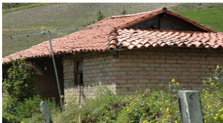
Figura 4-20: Vivienda en los páramos venezolanos, construida de manera repetitiva, siguiendo guías inadecuadas (Autor: Genatios, 2010).
