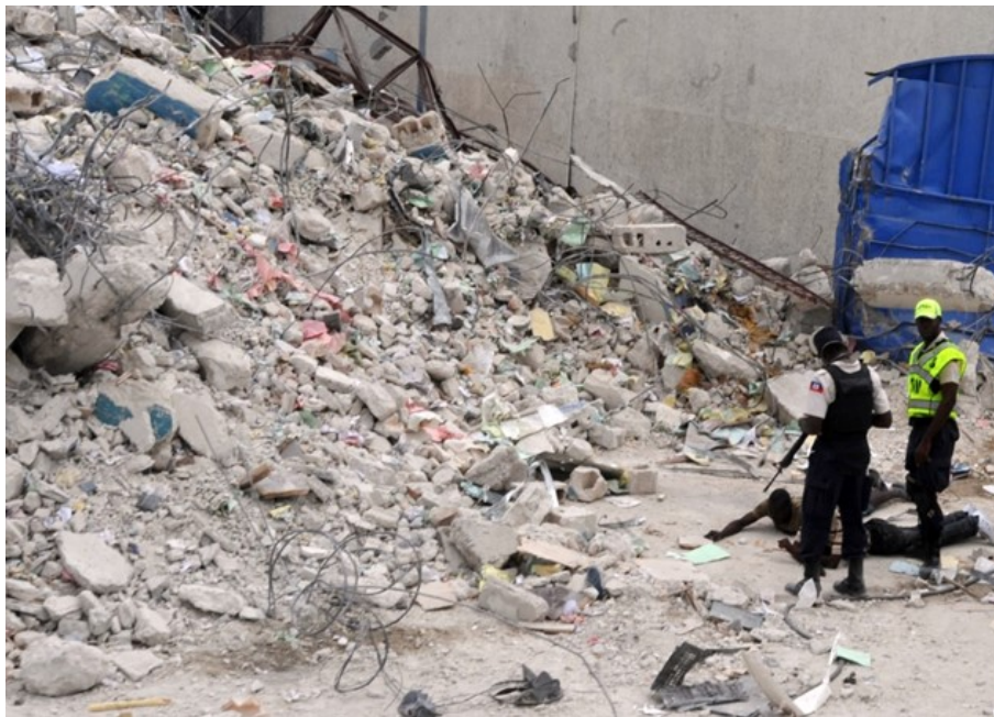
Figura 4-5: Daños en Haití, por el terremoto de 2010. (Autor: Casal Jr., 2010) 20
