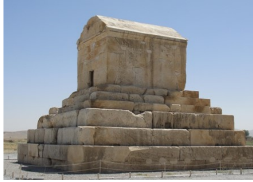
Figura 6-13: Tumba de Ciro el Grande, un caso de aislamiento sísmico en la antigüedad. 39
