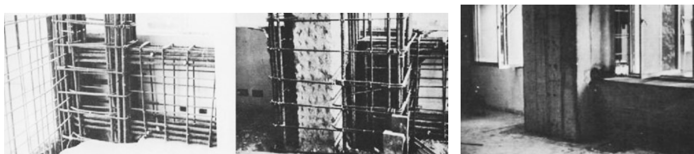
Figura 2-22: Detalles de refuerzo
