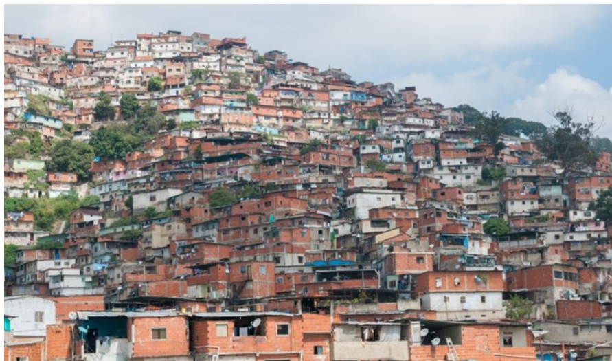
Figura 4-16: Viviendas de mampostería en Caracas. (Autor: The Photographer, 2013). 22
