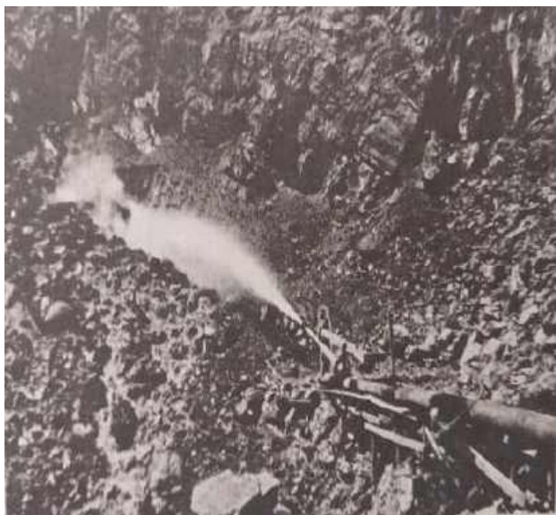
Monitor hidráulico en acción 1919. Tomado de Rohl (1963)
